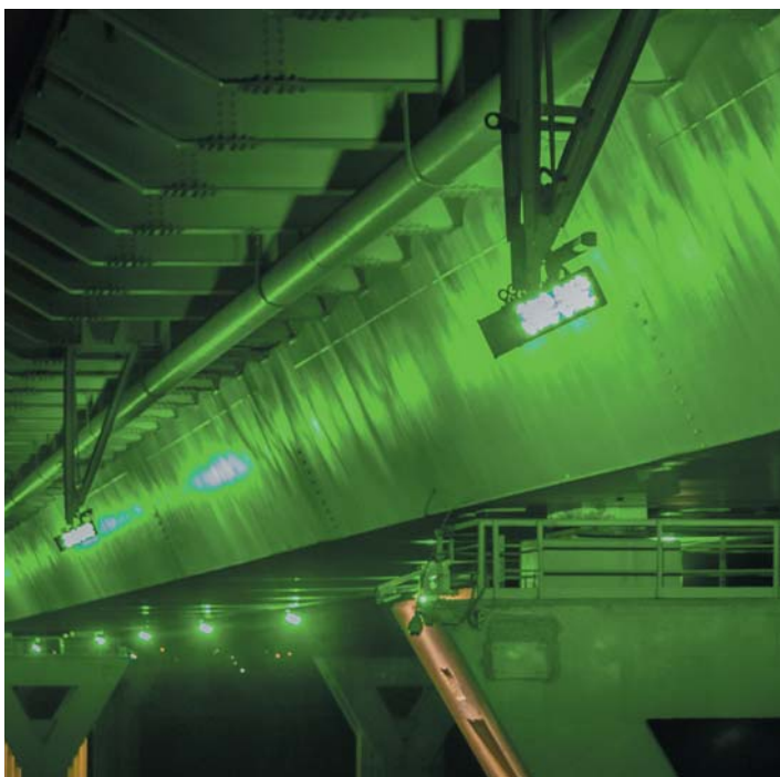
Рис. 5. Поверхность боковой части моста
